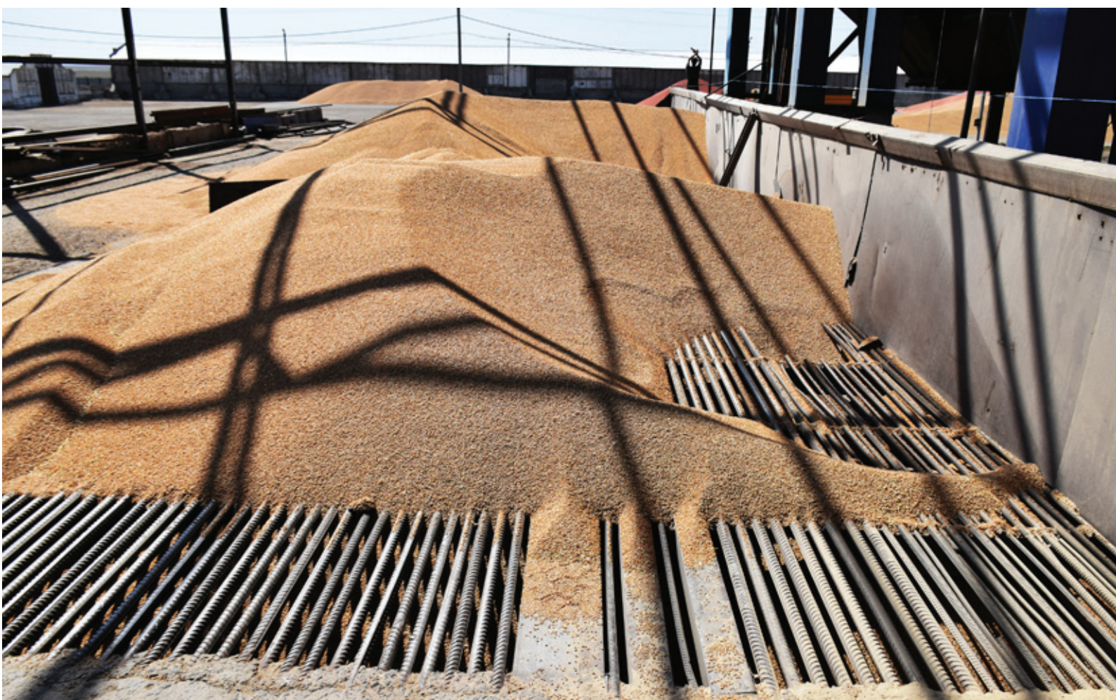
Загрузочный бункер для необработанного зерна с защитной решеткой
